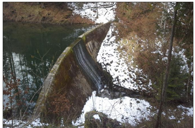
Abb. 9: Gefüllter Speicherteich eines Tiroler Kleinwasserkraftwerks
