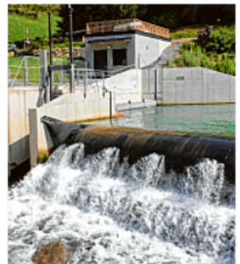
In Tirol gibt es rund 900 Wasserkraftanlagen. Symbolfoto: Stadtwerke Imst
