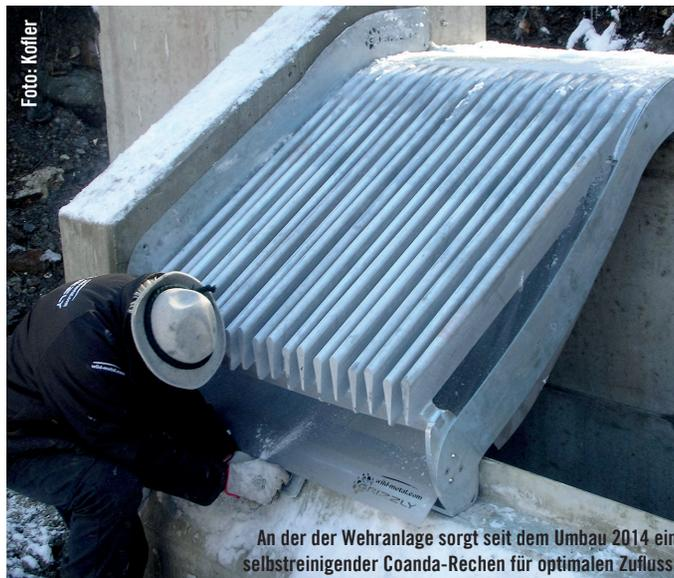
An der der Wehranlage sorgt seit dem Umbau 2014 ein selbstreinigender Coanda-Rechen für optimalen Zufluss.
