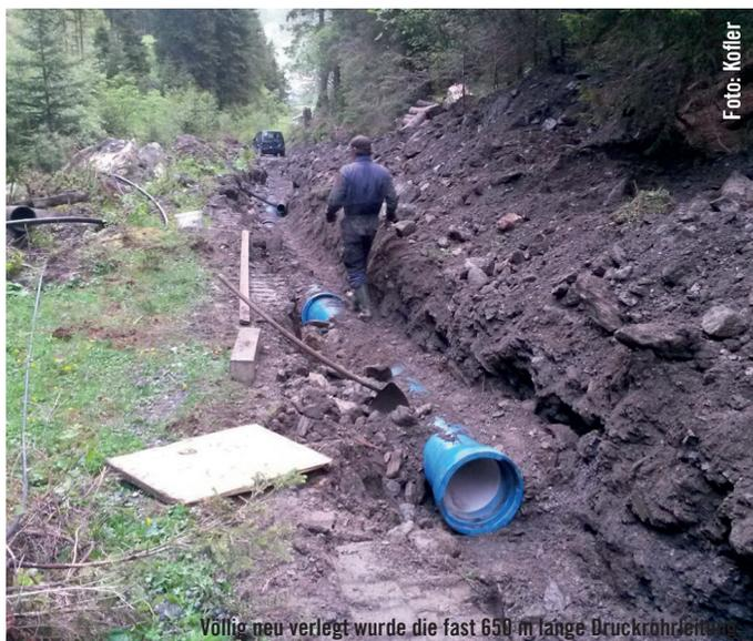
Völlig neu verlegt wurde die fast 650 m lange Druckrohrleitung.
